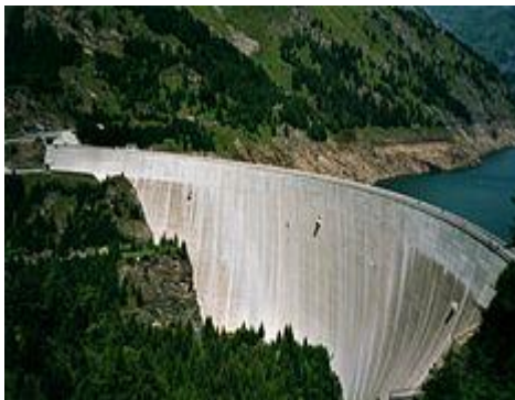
Diga del Luzzone
